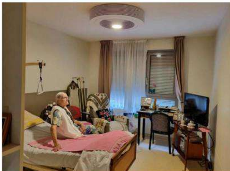
Dix destratificateurs d'air ont été installés dans les chambres les plus exposées au soleil de l'Ehpad de Voiron, avec un bouton de marche/arrêt placé à côté du lit. « Avant, raconte Danielle Dussert, pimpante octogénaire, j'avais un ventilateur personnel portatif. Là, je suis bien, je me mets en dessous pour lire, je respire. » Photos Le DL/H.D.
